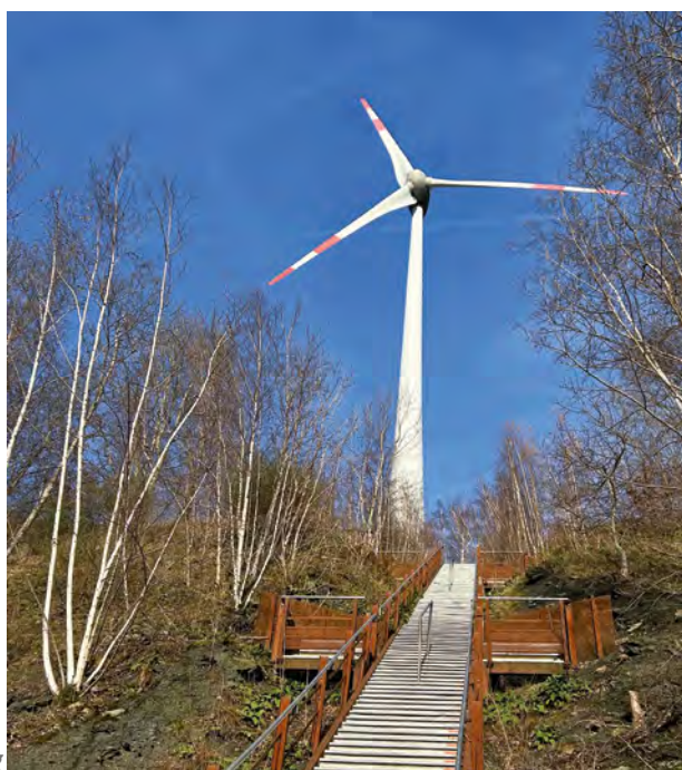
Ausblick auf Treppenaufstieg
