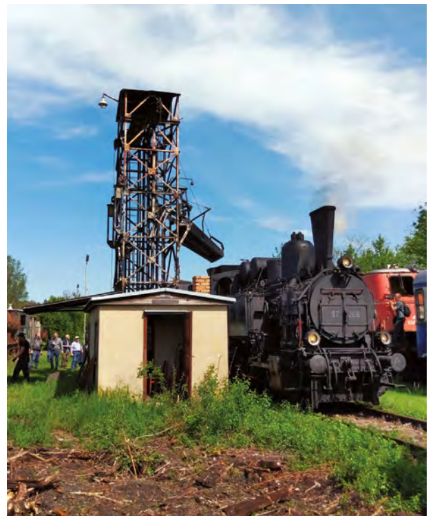
Museum Strasshof Bekohlungsanlage
