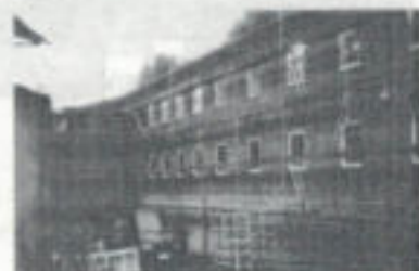
Das Werkgebäude während des Umbaus
