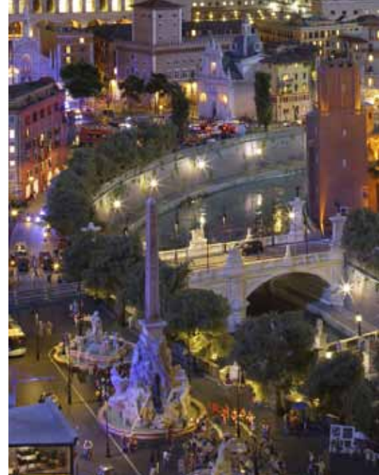
Tausende LED's beleuchten die Anlage
