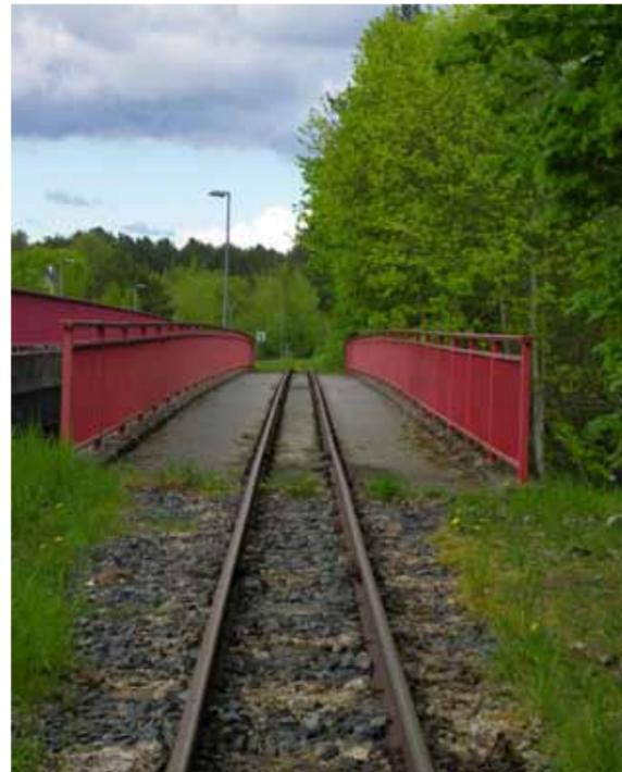
**Heute wird die 4 m breite und fast 55 m lange sanierte „alte“ Brücke nur noch durch die Feldbahn (750 mm) genutzt, da seit 2003 unmittelbar daneben die neue Straßenbrücke verläuft.**
