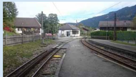
Grainau: Links Zahnstangengleis zur Zugspitze, rechts Adhäsionsgleis nach Garmisch
