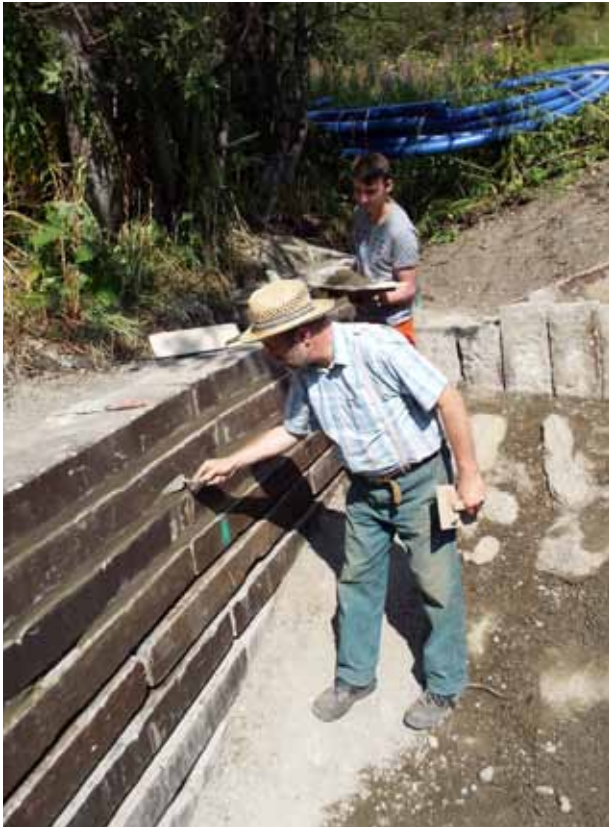
Der Wassereinlauf ist fertig. Heribert und Lukas müssen noch die Fugen zwischen den Granitsteinen verschmieren
