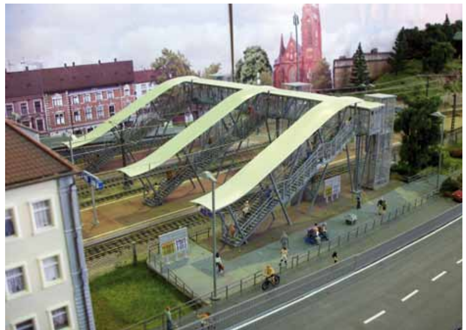
Gut gelungen, die moderne Bahnsteigbrücke von Fallers
