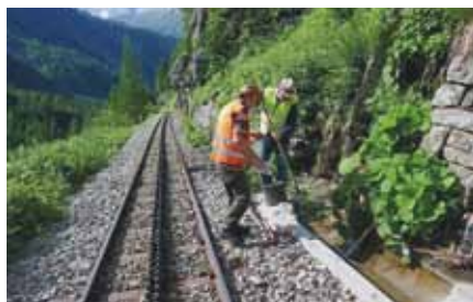
Bauwoche an der Furka-Bergstrecke
