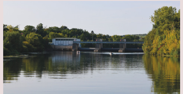
Blick vom Schiff auf die Schleuse Wipfeld
