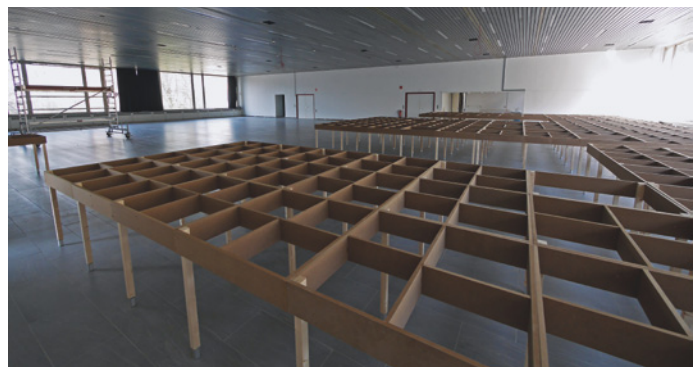
Unterkonstruktion Phase 1
