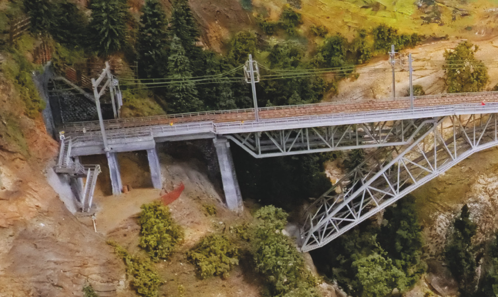
Oben: Bietschtal- brücke
