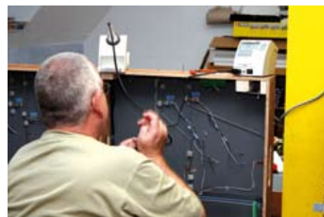
Unterirdische Technik bei der Geldernsche Kreisbahn
